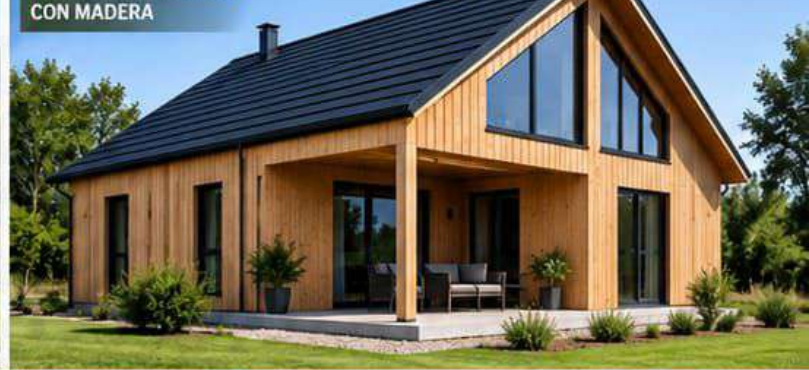
FASE 3 VIVIENDA TERMINADA CON MADERA
