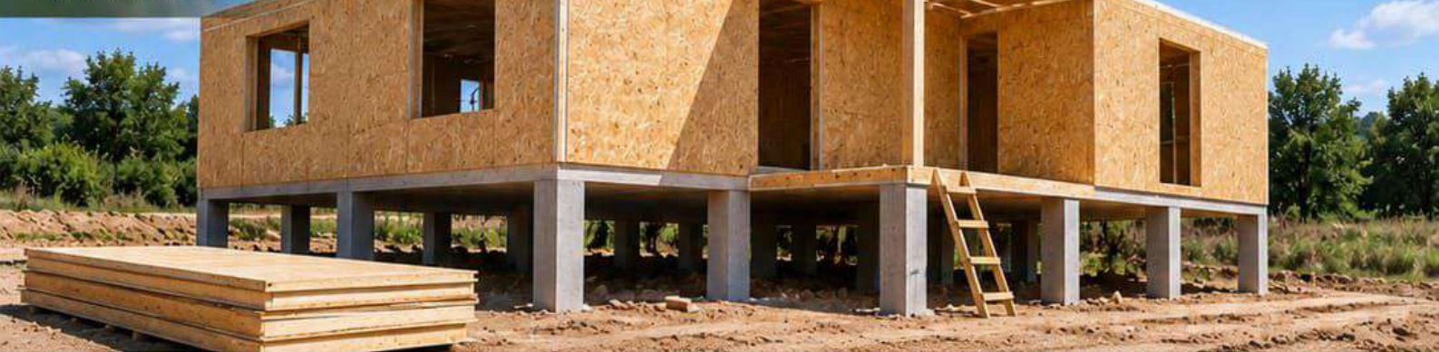
FASE 2 MONTAJE DE LA ESTRUCTURA Y CERRAMIENTOS
